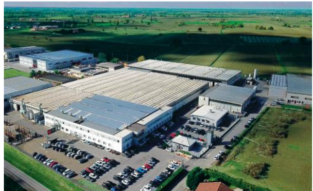
Рис. 1. Главный офис и фабрика Campitello.
