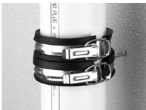
Запатентованная техника крепления RAUPIANO Plus к стене
