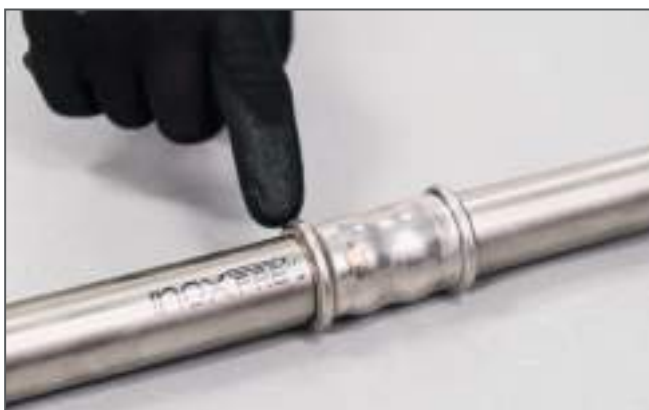
Controllo della pressatura / Checking the press connection
