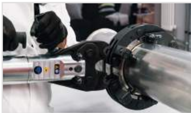
Assemblaggio pressatura n°1 / Press assembly phase 1
